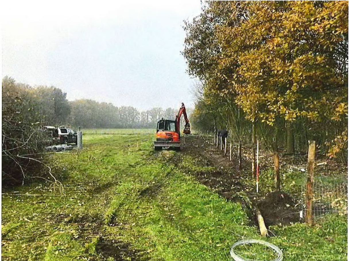
Foto 2: Kap van 4 meter stuk houtsingel en het naar binnen verplaatsen van het dassenraster.
